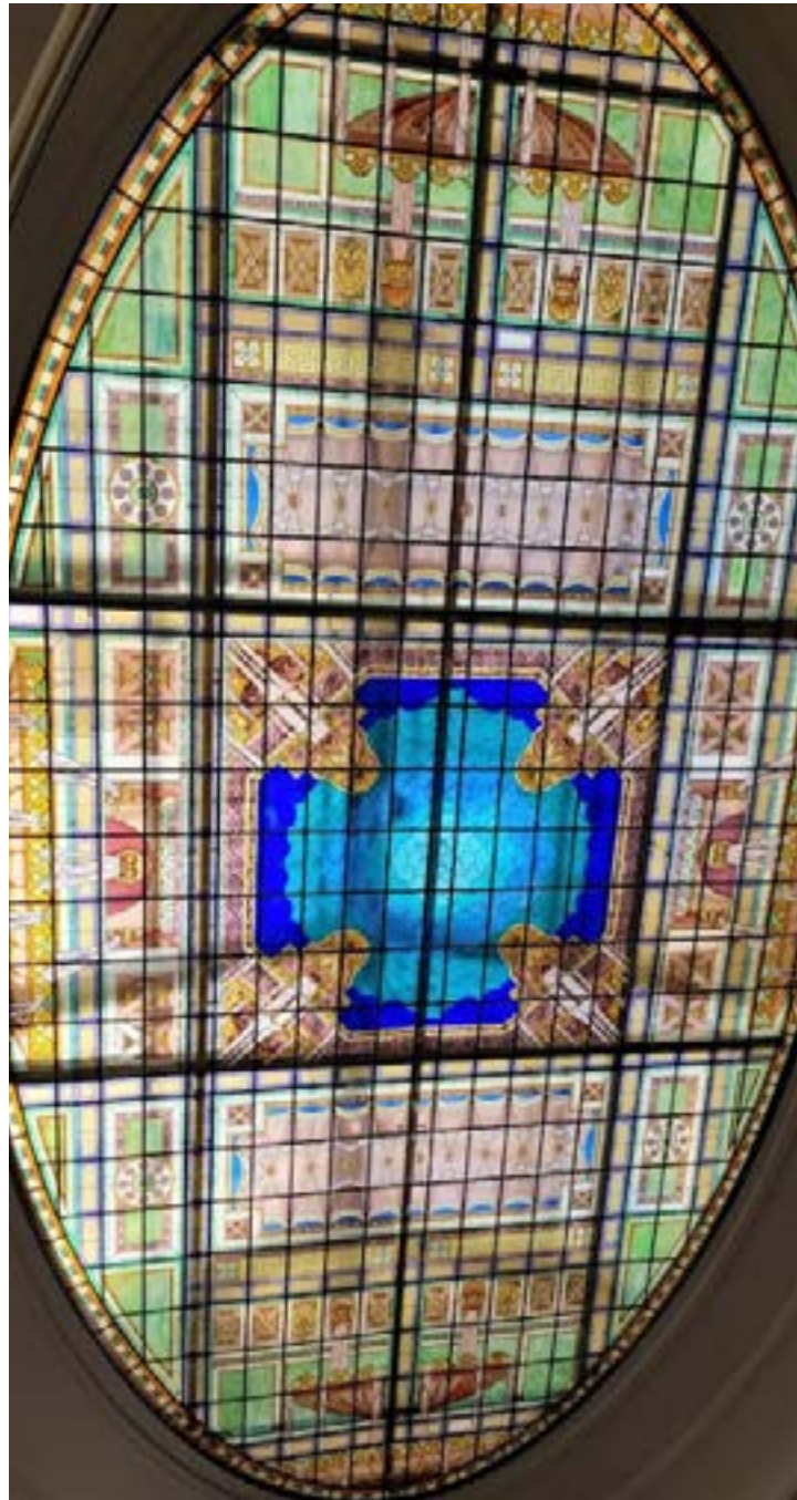
VITRAL foi recolocado após um trabalho de limpeza
