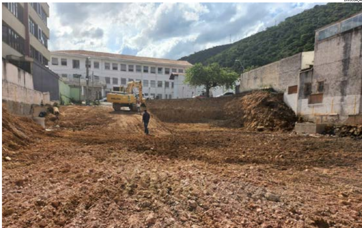
ETAPA da terraplanagem do terreno, de onde foi retirada toda terra até o subsolo, também já foi concluída
