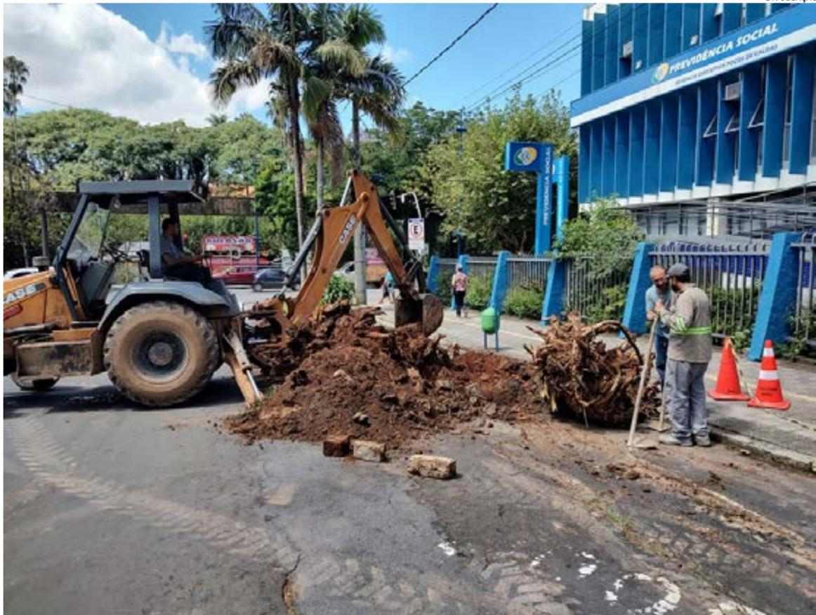
CANTEIRO antigo está sendo retirado para alargar pista e criar mais vagas de estacionamento; trecho segue interditado até a chegada de novas aduelas para tubulação
